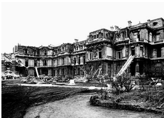
Bývalý Alfonsův vídeňský palác na Theresianumgasse před demolicí (1955), © SPÖ Wien
