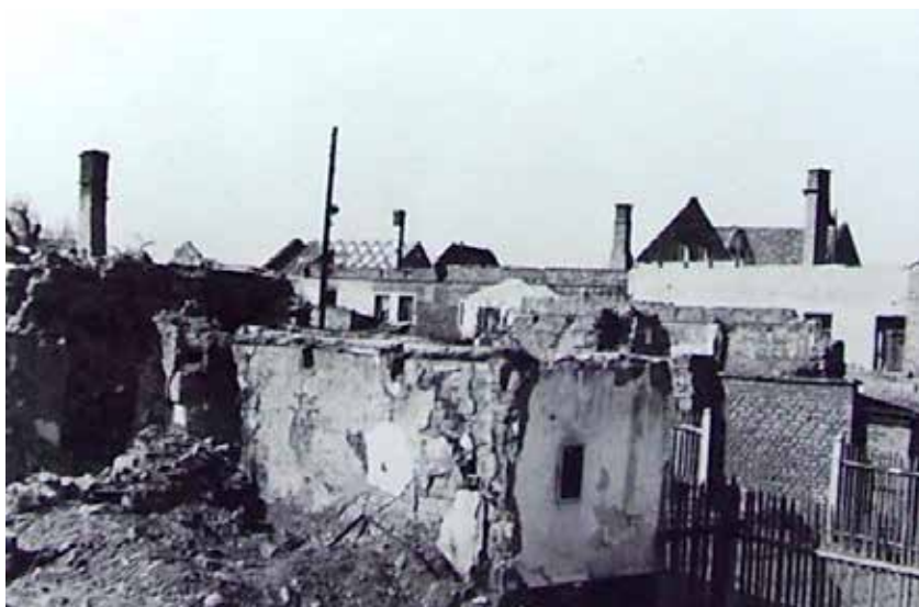
Přímé následky války byly na Hlučínsku obzvláště tíživé. Z mnoha obcí zůstaly pouze trosky... SOkA Opava, f. MNV Kouty, pamětní kniha 1945–1954.
